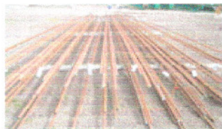
Vérification de la ferrailage avant mise en œuvre
